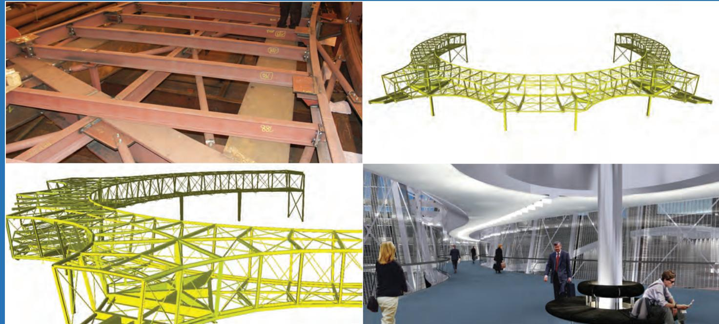
Ils s'appuient à leurs extrémités sur des tubes extérieurs de diamètre 273 mm cintrés dans le plan horizontal.
